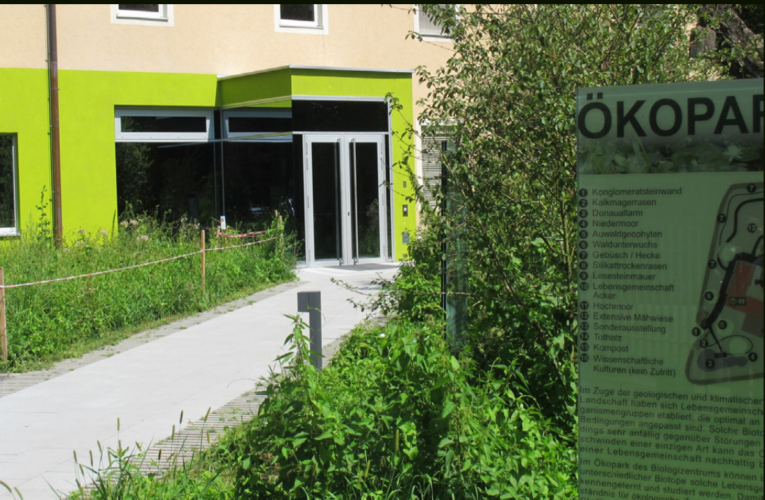
UMBAU BIOLOGIEZENTRUM | ÖKOPARK LINZ
